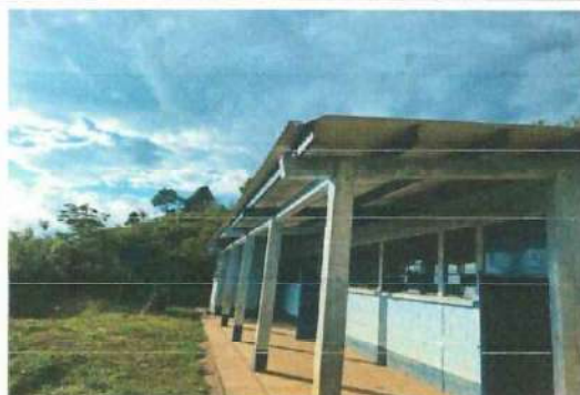
Foto 2: Se observa la necesidad de colocar canales para bajada de agua pluvial
