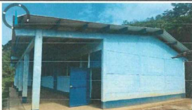
Foto 5: Se observa la necesidad de cernir las paredes del establecimiento educativo para evitar filtraciones de agua y humedad posteriormente pintar la escuela.
