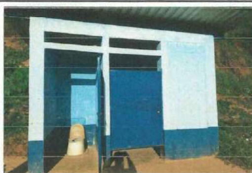
Foto 6: Se observa la necesidad de cambiar las tazas de los sanitarios por tazas lavables.
